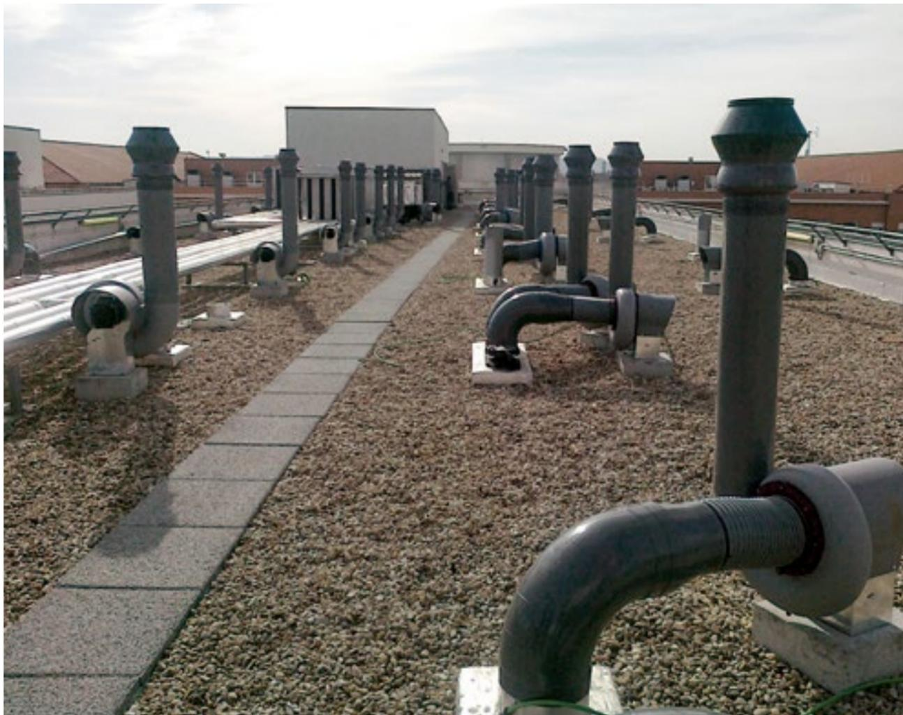
**Ventiladores centrífugos para extracciones corrosivas (CPV):** Ventilador envolvente y turbina con alabes en polipropileno. Transporta el aire a una temperatura máxima de  $-20^{\circ}\text{C}$   $+70^{\circ}\text{C}$ . Los motores estándar son trifásicos de 230/400V y una frecuencia de 50Hz hasta 5,5CV de potencia y 400/690V y 50Hz para potencias mayores a 5,5CV. Aislamiento clase F y protección IP55. En caso de necesidad el motor puede ser suministrado con certificación categoría 3-ATEX .
